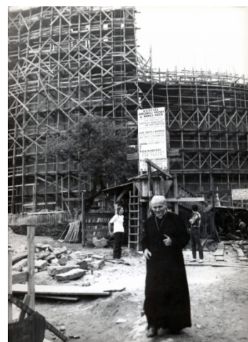
4. Obispo Wojtyla durante las obras
